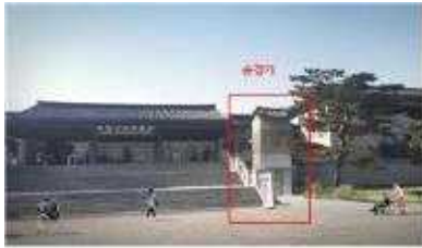
전시동 진입부 승강기 설치
